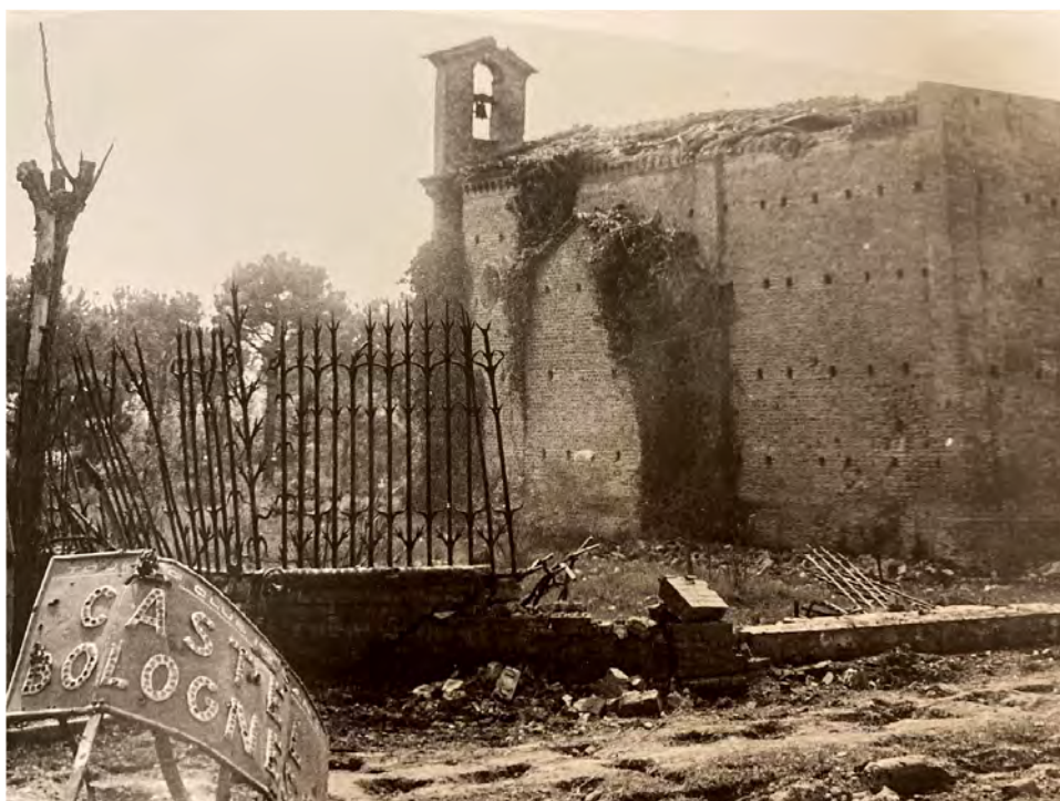
La chiesa del sec. XV di San Sebastiano posta all'ingresso ovest di Castel Bolognese sulla Via Emilia verso Imola (aprile 1945).
