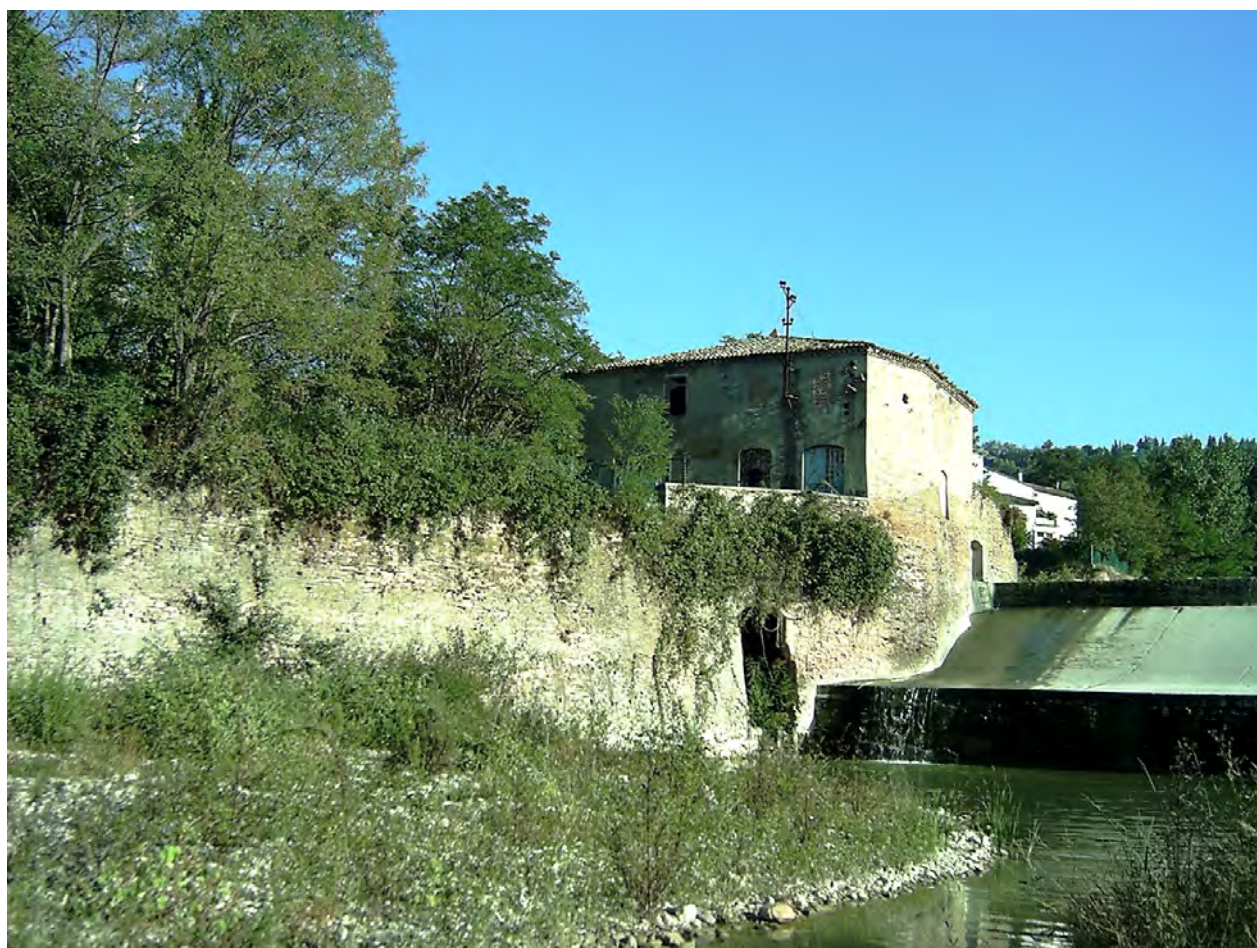
Lo sbarramento sul Savio, dal quale si origina il Canale dei Mulini dal XIV secolo.
