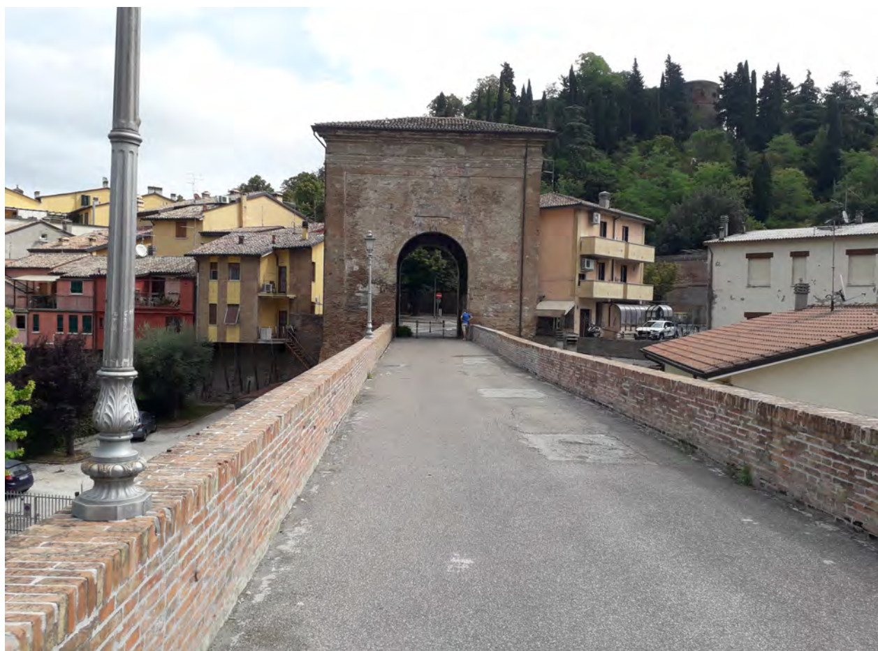
Il ponte di San Martino e la Porta Fiume, la più antica di Cesena.
