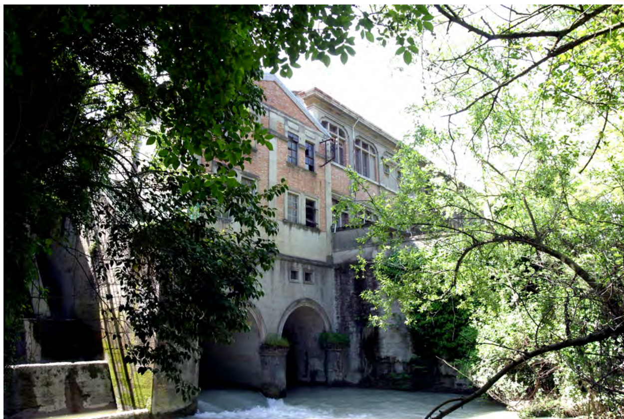
Il "Canale dei Mulini" alimenta da più di un secolo la Centrale Idroelettrica di Brenzaglia, ancora oggi in funzione.
