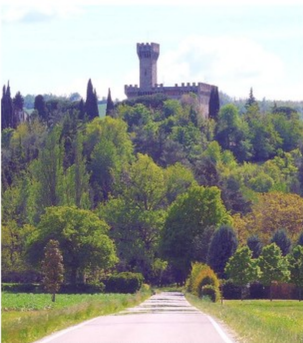
Il Castello Rangoni Macchiavelli, finto-medievale costruito a fine '800 nei pressi di Castel dei Britti dai marchesi Malvezzi Campeggi.
